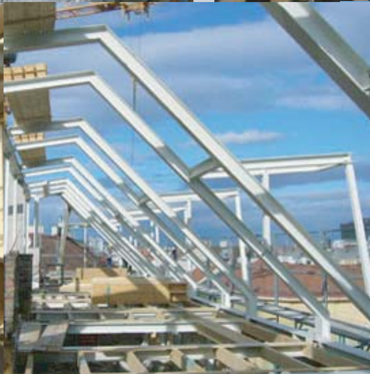
AUFSTOCKUNG (4.STOCK) und DACHGESCHOSSAUSBAU als STAHLKONSTRUKTION
