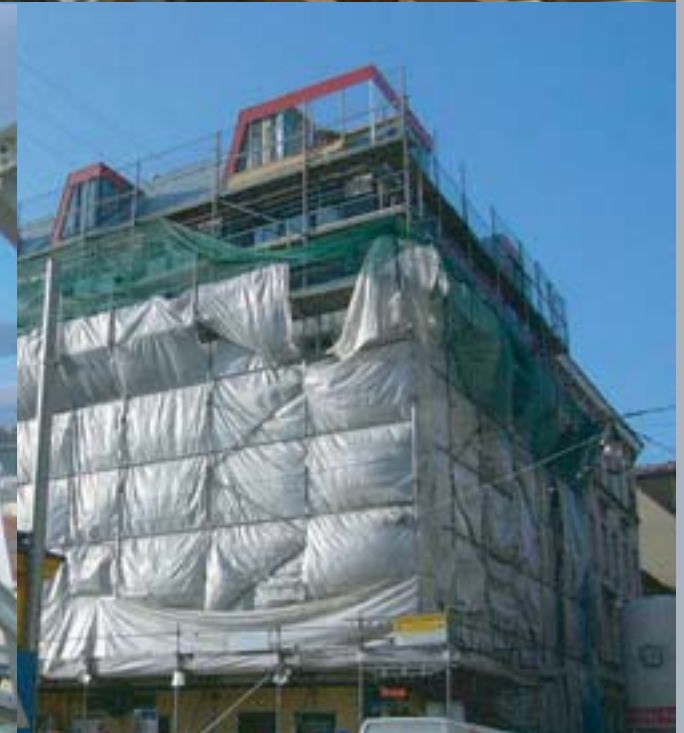
AUFSTOCKUNG (4.STOCK) und DACHGESCHOSSAUSBAU als STAHLKONSTRUKTION
