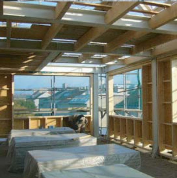
AUFSTOCKUNG (4.STOCK) und DACHGESCHOSSAUSBAU als STAHLKONSTRUKTION
