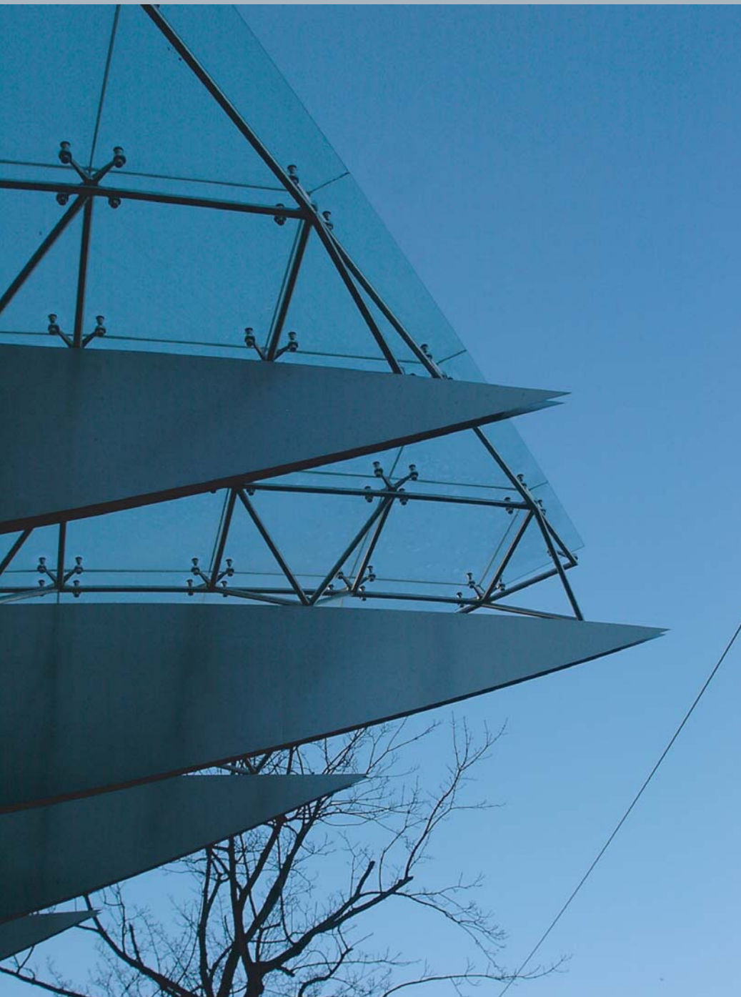
NACHTRÄGLICHER ANBAU FLUGDACH
