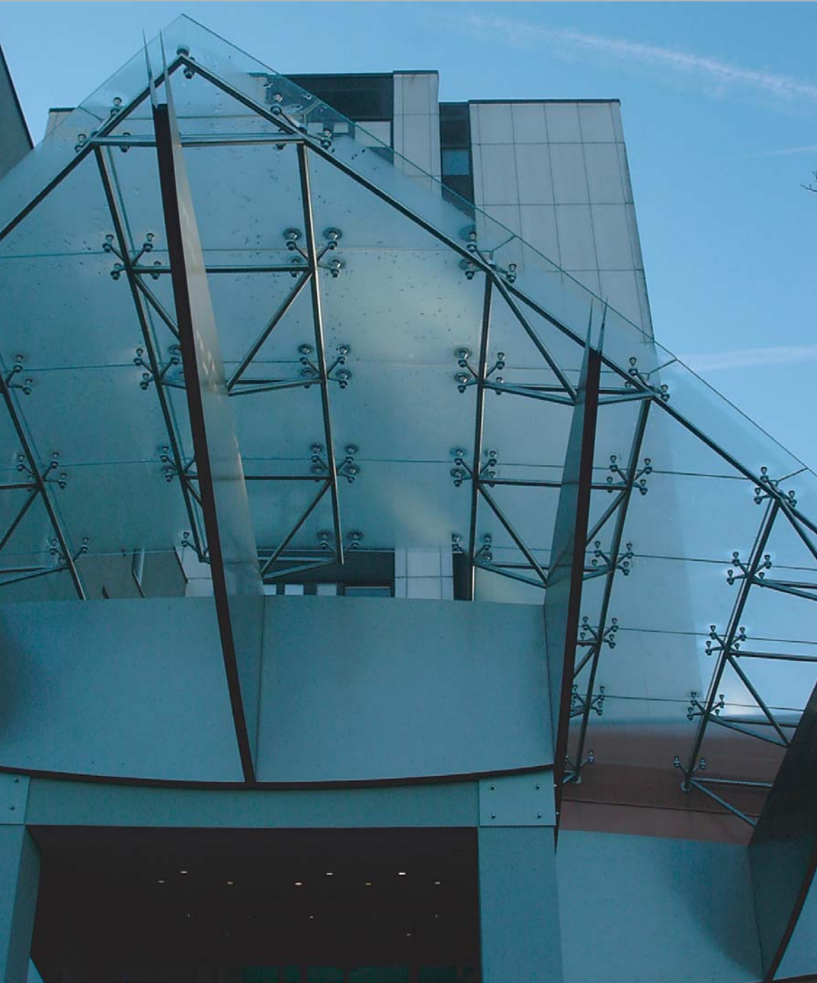
NACHTRÄGLICHER ANBAU FLUGDACH
