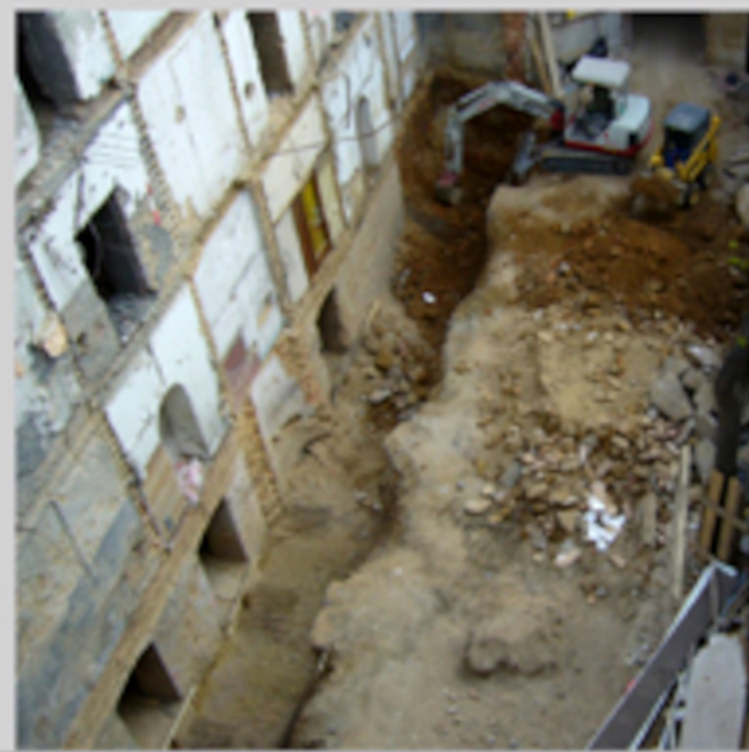
ABBRUCH DER HOFSEITE BIS ZUR MITTELMAUER
