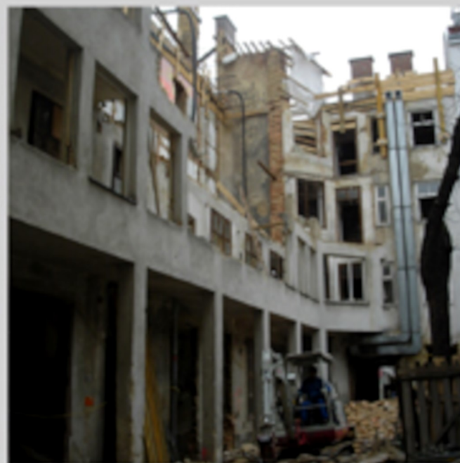
SOCKELSANIERUNG, ABBRUCH ab der MITTELMAUER, ZUBAU / AUFSTOCKUNG und DG_AUSBAU
