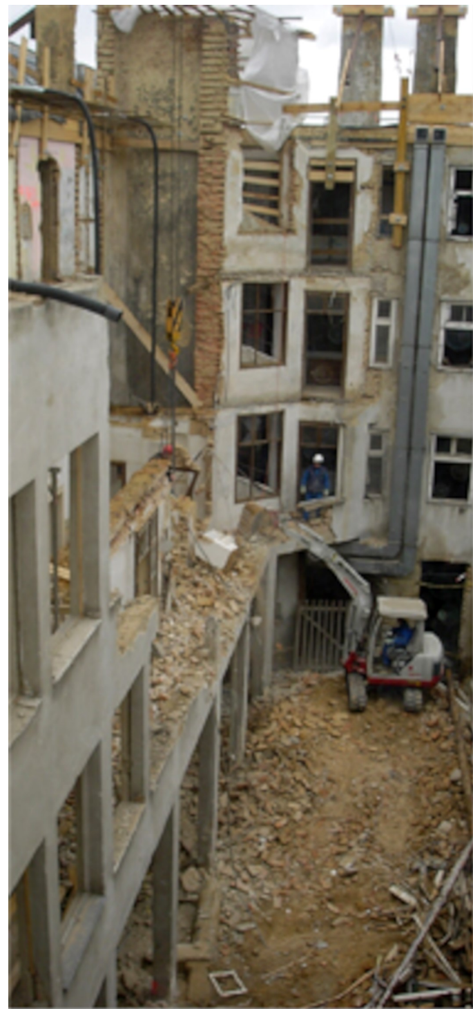
ABBRUCH DER HOFSEITE BIS ZUR MITTELMAUER
