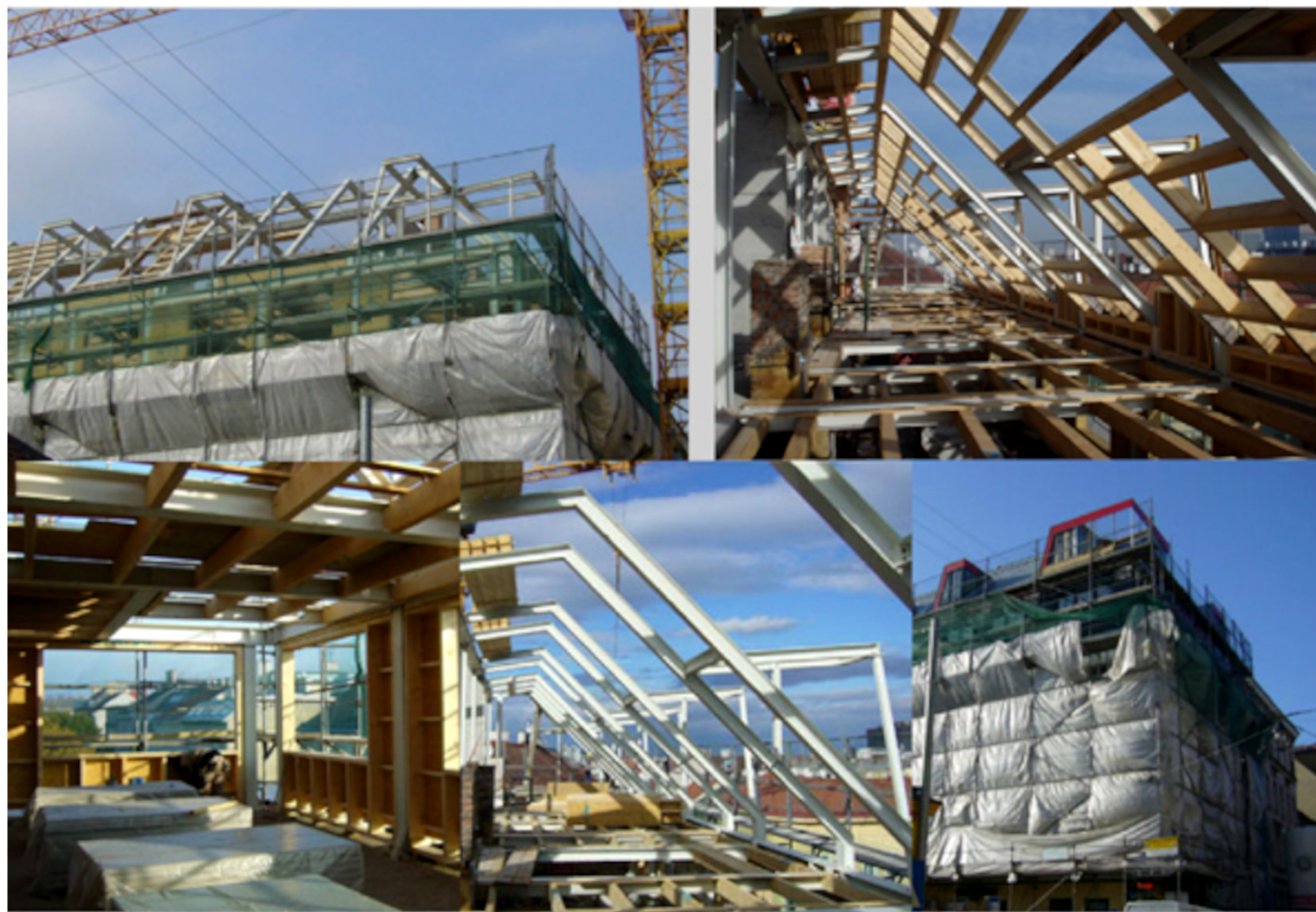
AUFSTOCKUNG (4.STOCK) und DACHGESCHOSSAUSBAU als STAHLKONSTRUKTION
