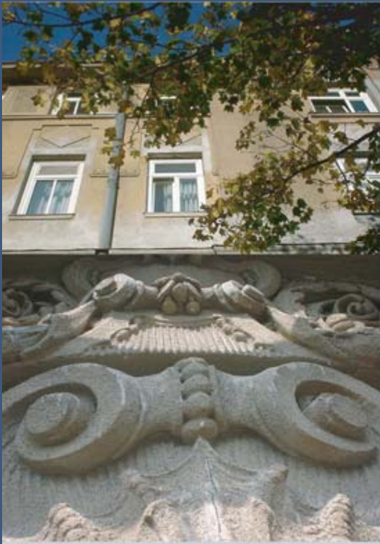
SOCKELSANIERUNG OHNE DACHGESCHOSSAUSBAU
