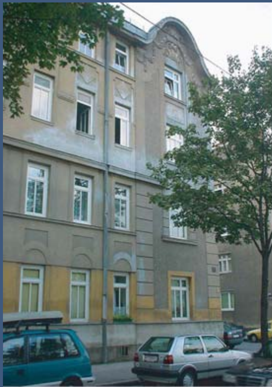
SOCKELSANIERUNG OHNE DACHGESCHOSSAUSBAU
