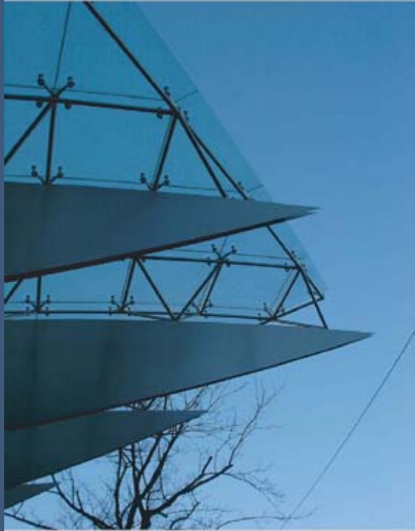
NACHTRÄGLICHER ANBAU FLUGDACH
